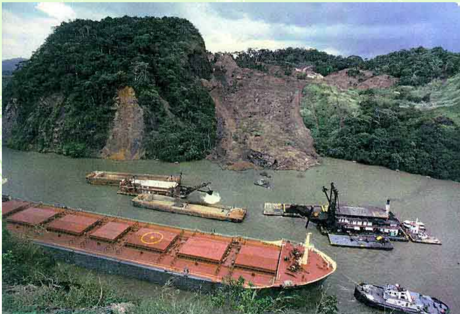
Работы по очистке русла канала от оползня
